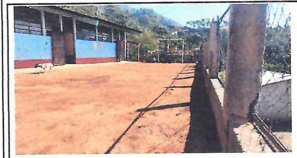
Foto 5: Losa de patio
