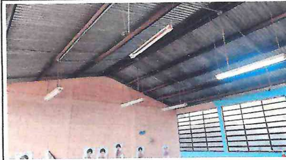
Foto 2: Estructura de techo
