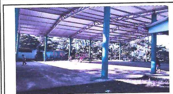
FOTO 3: ESTRUCTURA DE TECHO Y CUBIERTA DE LAMINA FINALIZADA
