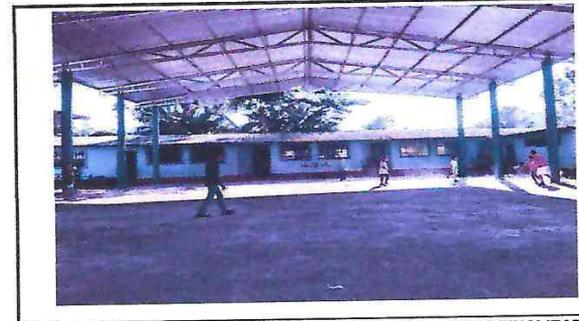
FOTO 4: ESTRUCTURA DE TECHO Y CUBIERTA DE LAMINA FINALIZADA
