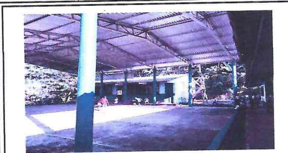
FOTO 1: ESTRUCTURA DE TECHO Y CUBIERTA DE LAMINA FINALIZADA
