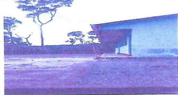
Foto 2: Losa de patio en mal estado sin cubierto de láminas y estructura de techo.
