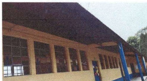
Foto 10: Vista general de modulo de aulas.
