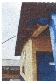
Foto 9: Vista lateral de modulo de aulas.
