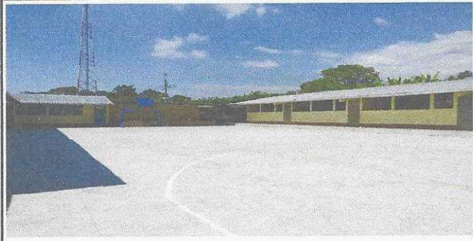
1. losa de patio
