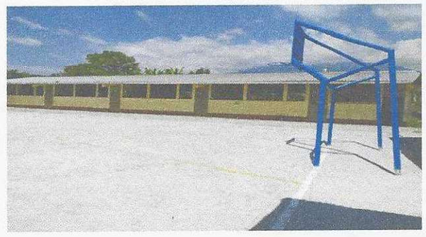
2 losa de patio finalizado
