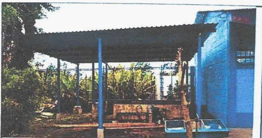
Foto 4: Reparación o sustitución de área de cocina
