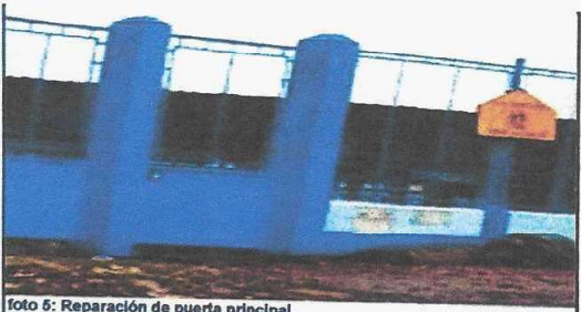
foto 5: Reparación de puerta principal
