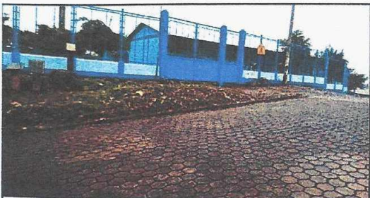
Foto 3: Pintura de circulación
