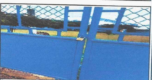
Foto 6: Mantenimiento de portones
