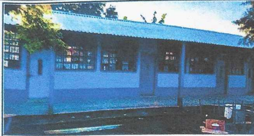
Foto 1: Cubierta de lámina
