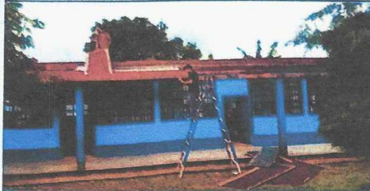
Foto 1: Cubierta de lámina
