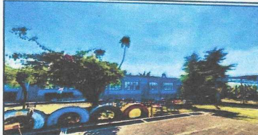
Foto 2: Pintura de costanera
