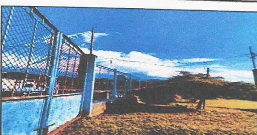
Foto 6: Mantenimiento de portones
