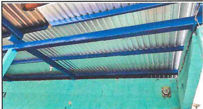
Foto 3. Cambio de Costaneras de madera.
