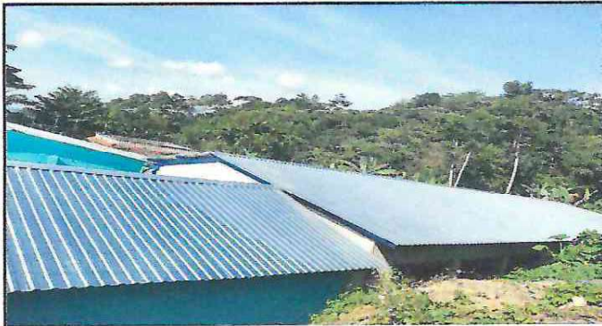
Foto 1: Cambio de techado y capotes de dos aula.
