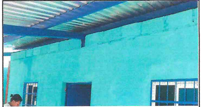
Foto 2: Cambio del techado del salón.
