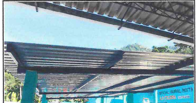
Foto 4: Cambio de techado de Galera.
