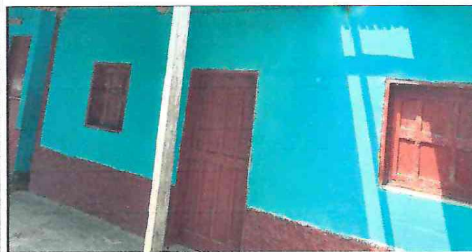
Foto 5: Cambio de tres ventanas y una puerta de madera.
