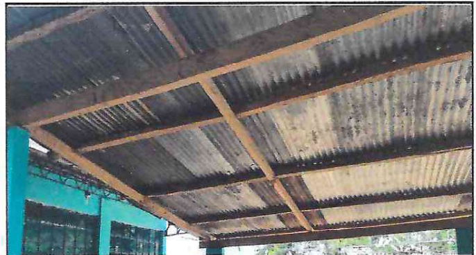
Foto 4: Cambio de techado de galera.
