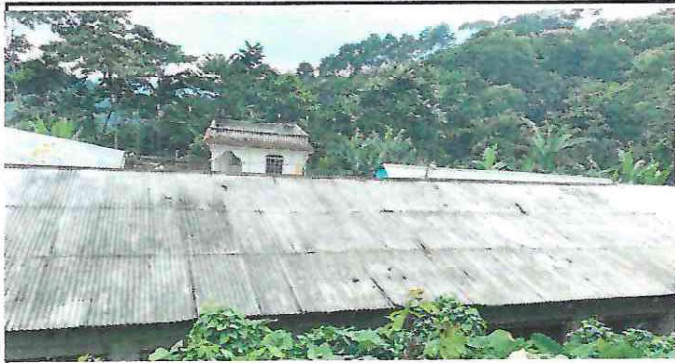
Foto 1: Cambio de techado capotes de dos aulas.
