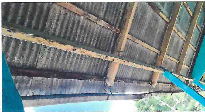
Foto 3: Cambio de costaneras de madera.
