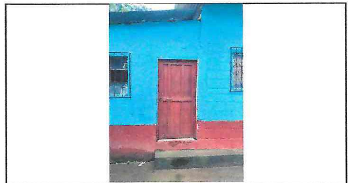
Foto 6: Cambio de puerta de madera/bodega.
