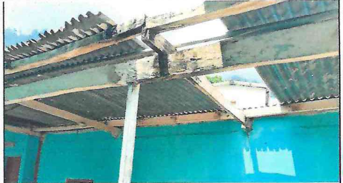
Foto 2: cambio de techado del salón.
