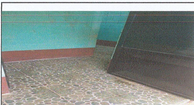
Foto 5: pisos instaladas en los sanitarios
