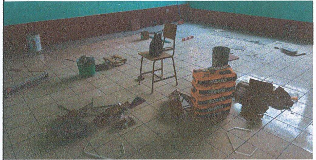
Foto 2: pisos terminado su colocacion
