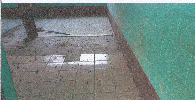
Foto 3: Colocacion de Pisos
