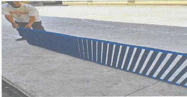
foto 2: colocación de rejias
