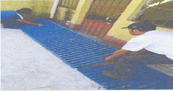
foto:1 colocacion de rejias
