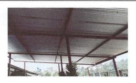
Foto 3: Cubierta de lamina y estructura portante requiere cambio, debido deterioro e inclemencias del tiempo.
