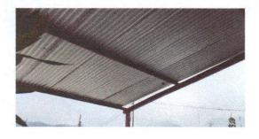
Foto 1: Cubierta de lamina y estructura portante requiere cambio, debido deterioro e inclemencias del tiempo.
