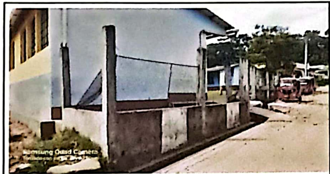
FOTO 1: LADO SUR DEL MURO PERIMETRAL
