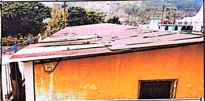
Cubierta de lámina del establecimiento esta muy deteriorado urge cambiarlo.
