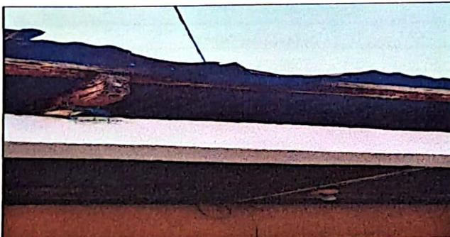
Urge cambiar estructura de techo de 4 aulas por deterioro.
