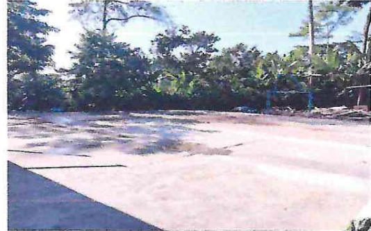
Foto 2: Losa de Patio Finalizado
