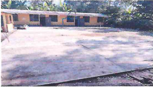
Foto 1: Losa de Patio Finalizado
