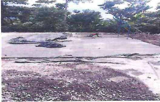
Foto 1: Reparación de Losa de Patio
