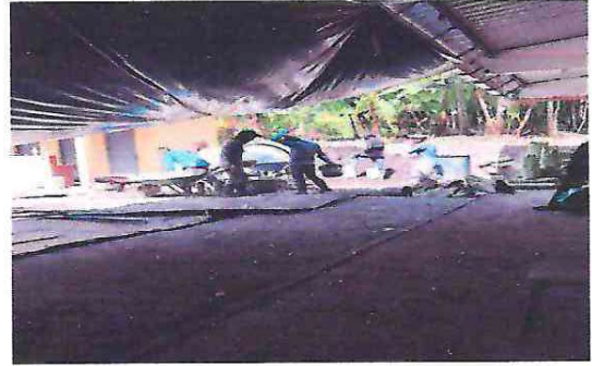
Foto 2: Reparación de Losa de Patio
