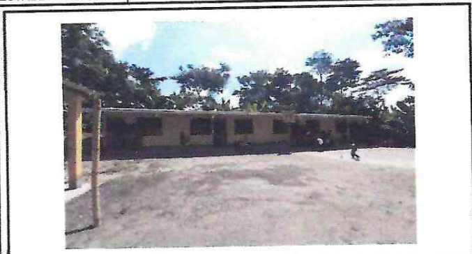
FOTO: 1 Reparación de plancha de concreto de patio
