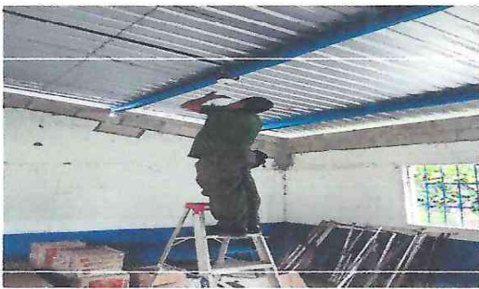
Foto 5: Mantenimiento de energía eléctrica
