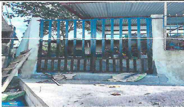
Foto 3: Mantenimiento a portón
