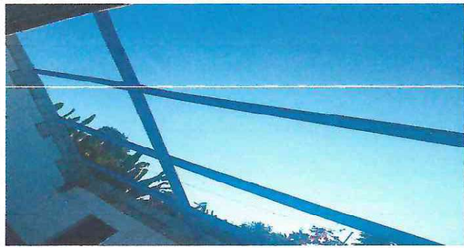
Foto 1: Cubierta de lámina
