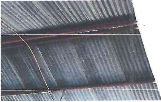
Foto 1. Cubierta de lámina
