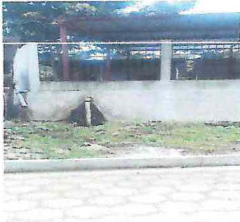
Foto 3. Mantenimiento a portón
