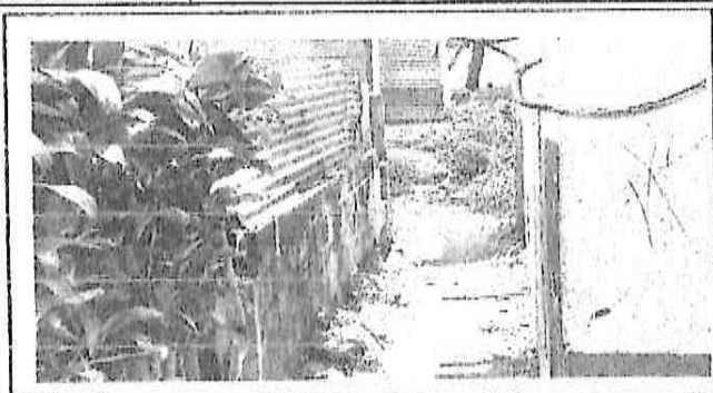
Foto: Reparación de muro perimetral.
