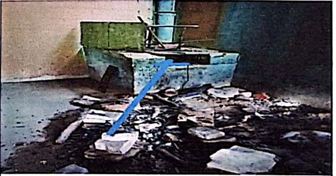
FOTO 6 reparacion de estufa rural.
