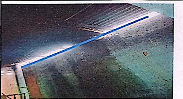
FOTO No. 3 reparacion techo de cocina y su pintada
