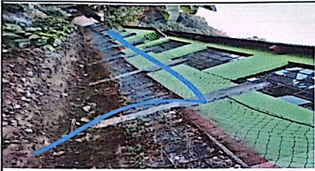
foto no. 1 reparación de circulación por deterioro.
