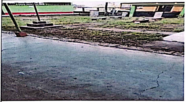
foto No. 4 reparacion losa de patio escolar
