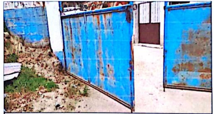
Foto 4: Mantenimiento a portones
