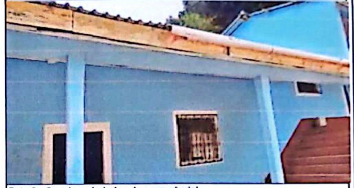
Foto 2: Canales y bajadas de agua pluvial
