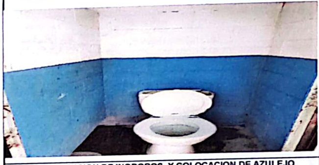
FOTO 2 SUSTITUCION DE INODOROS. Y COLOCACION DE AZULEJO
