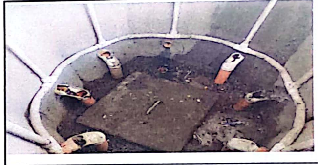
FOTO 4 REPARACION DE REPOSADERA
