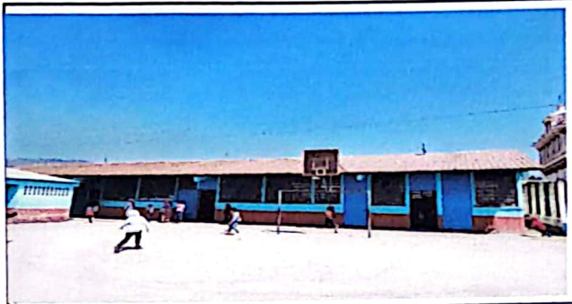
FOTO 1: CAMBIO DE TECHADO DE AULAS
