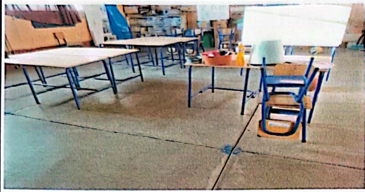
Foto 1: Aula 1, piso con torta de cemento, tercero primaria. Instalación de piso cerámico y pintada del aula interna y externa.
