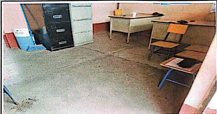
Foto 4: Dirección y bodega, piso con torta de cemento. Instalación de piso cerámico y pintada interna y externa de ambos espacios.
