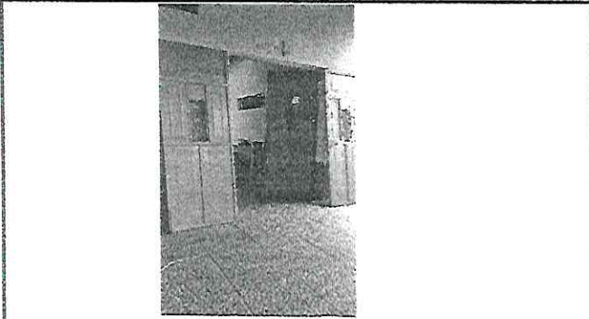
Foto1. Sustitucion de puertas en proceso.
