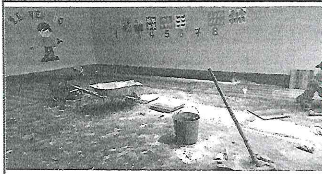
Foto 2. Colocacion de pisos en las aulas de Ceibi Preprimaria y Parvulo en proceso
