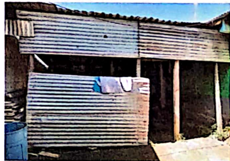
Foto 6: Reparación de muro perimetral
