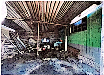
Foto 5 : Reparación de muro perimetral
