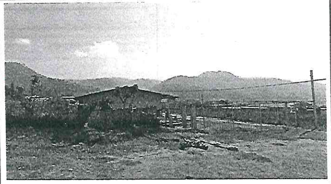
Foto 2: AULAS QUE NECESITAN CIRCULACIÓN
