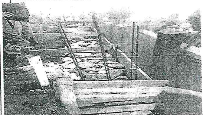
Foto 2: COLOCACION DE LAS PIEDRAS
