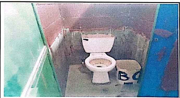
Foto 4: Cambio de Inodoros de niños
