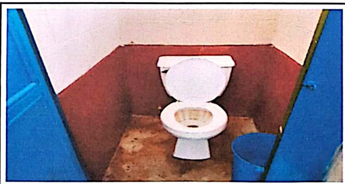
Foto 5: Cambio de Inodoros de niñas
