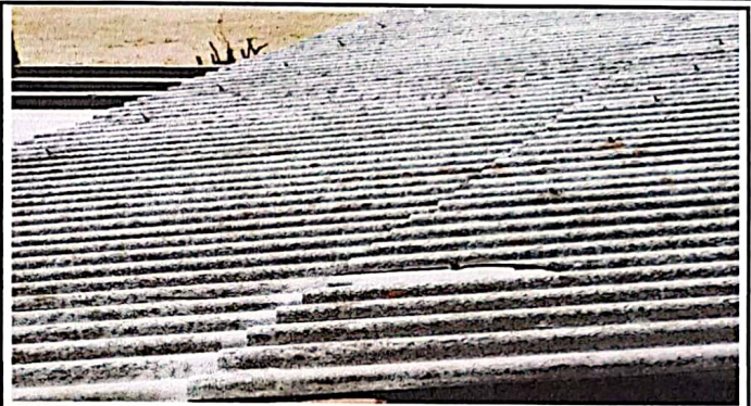
Foto 2: cambio de techado del aula
