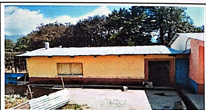
Foto 6: Cambio de techado de la cocina.
