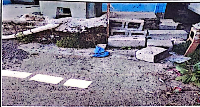
Foto 13: Reparación de muro frente a la aulas del modulo 2
