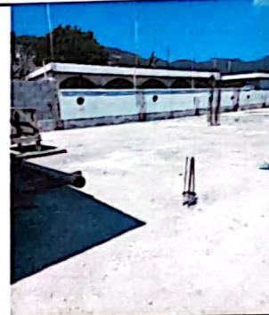
Foto 4: Reparación de láminas
