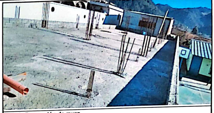
Foto 2: Reparación de muro
