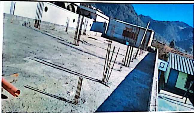
Foto 1: Instalación de piso
