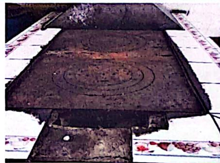
Foto 4: Plancha y el poyo de la cocina en mal estado
