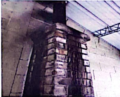
Foto 1: Chimenea de la cocina en mal estado
