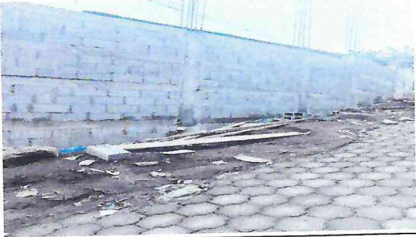
Foto: Obra culminada
