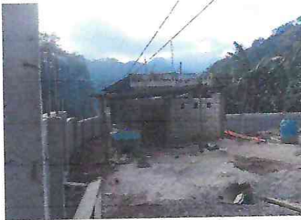
Foto 3: En proceso de construcción.
