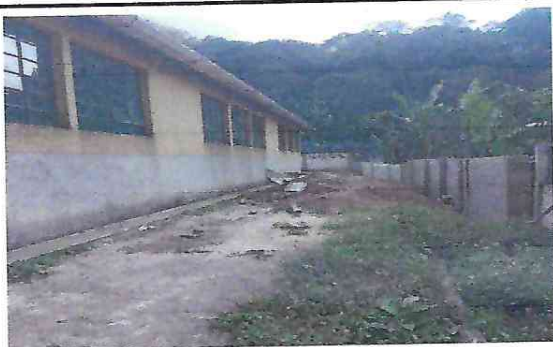
Foto 5: En proceso de construcción.
