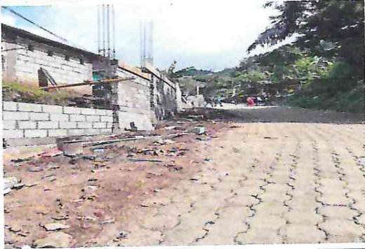
Foto 1: En proceso de construcción.
