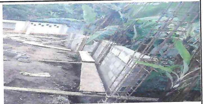
Foto 4: En proceso de construcción.
