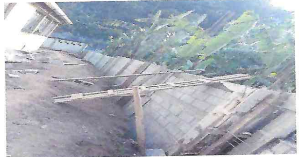
Fotos 6: En proceso de construcción.
