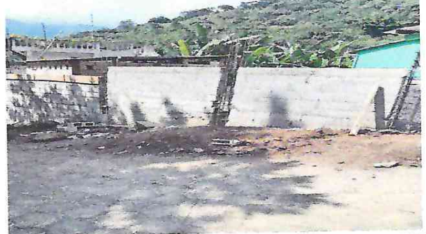
Foto 2: En proceso de construcción.
