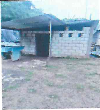
FOTO 3. no cuenta con estufa normal de leña no esta repellado y no tiene torta de cemento.
