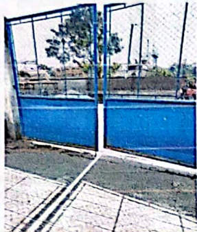
Foto 1: Dereritorio de metal en la parte inferior del portón.
