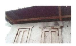
Foto 3: Cubierta de techo y estructura portante en servicios sanitarios 1 requiere cambio.
