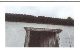
Foto 5: Cubierta de techo y estructura portante en area de pila requiere cambio.
