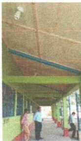
Foto 5: Vista general de pasillo en modulo de aulas 1.
