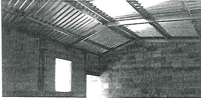
Foto 1: TECHADO Y PARALES CAMBIADOS
