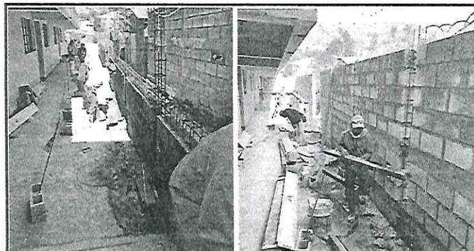
Foto 6: SUSTITUCION DE MURO PERIMETRAL
