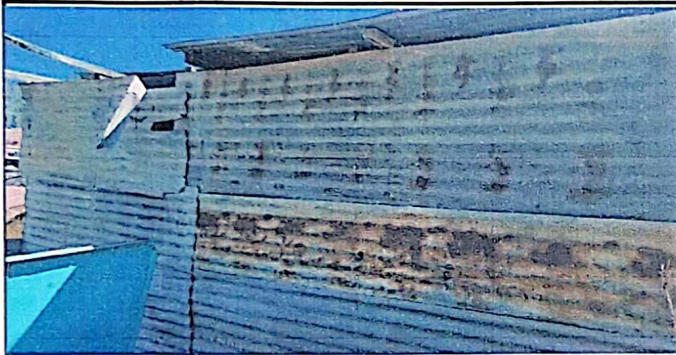
Foto 1: Cambio de techado y parales
