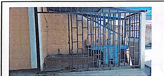
Foto 3: mantenimiento de barandas
