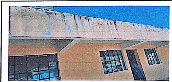
Foto 4: Pintar aulas parte exterior
