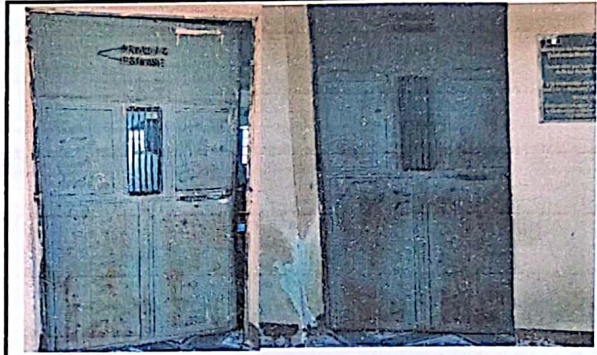
Foto 2: Sustitución y mantenimiento de puertas
