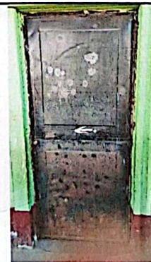
Foto 6: Sustitución de puerta de metal.
