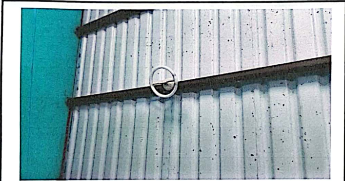
Foto 9: Sustitución de lámparas en las aulas.
