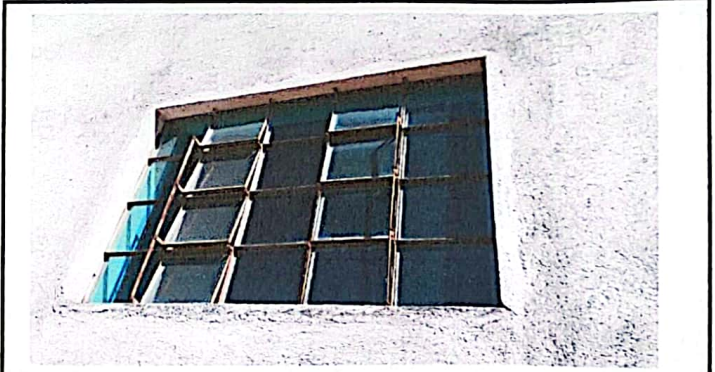
Foto 10: Instalación de balcones en las ventanas de las aulas.
