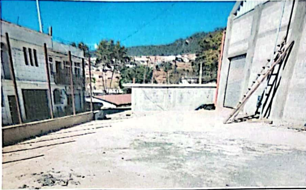
Foto1: Torta de Cemento en el Patio.
