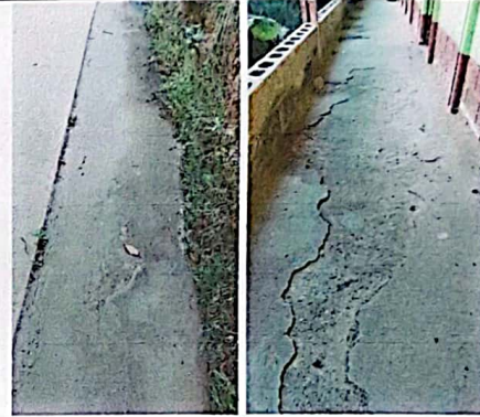
Foto 4: Construcción de cunetas en frente de las aulas.
