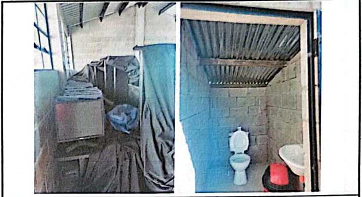
Foto 8: Instalación de energía eléctrica en el centro de computación y baños.
