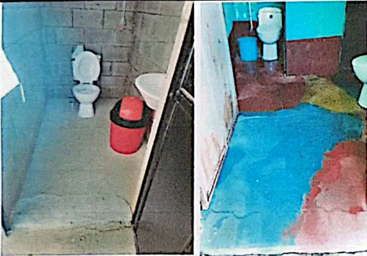
Foto 3: Sustitución de torta de cemento a piso cerámico en los servicios sanitarios.
