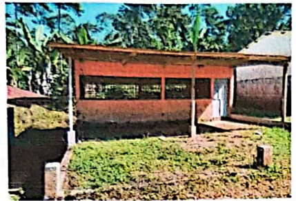
Foto 1: Cubierta de Lamina
