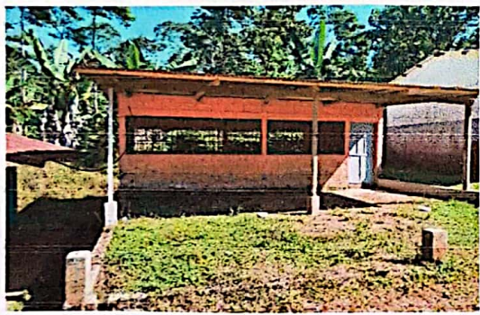
Foto 3: Cambio de piso y Canaletas
