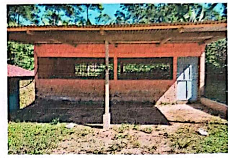
Foto 2: Estructura de Techo
