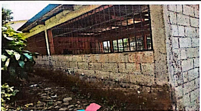
Foto 5: Cambio de balcones
