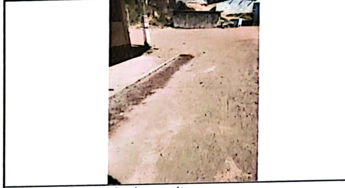
Foto 2: Sustrucción de piso de concreto
