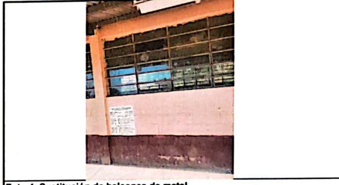
Foto 4: Sustrucción de balcones de metal
