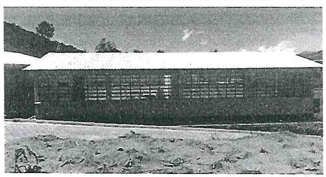
Foto 2: Nuevo techado de láminas troqueladas calibre 26
