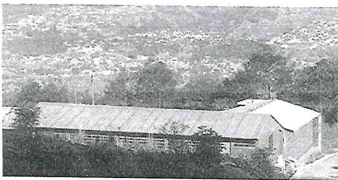
Foto 3: Nuevo techado de láminas troqueladas calibre 26
