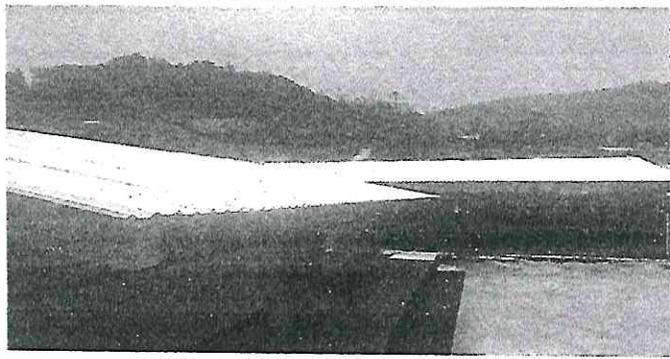
Foto 1: Nuevas techado de láminas troqueladas calibre 26
