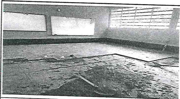
Foto 5: Instalación de pisos de granitos en aula 2
