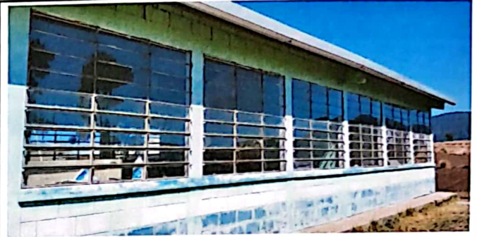
Foto 2: Sustitución de ventanas por valcones
