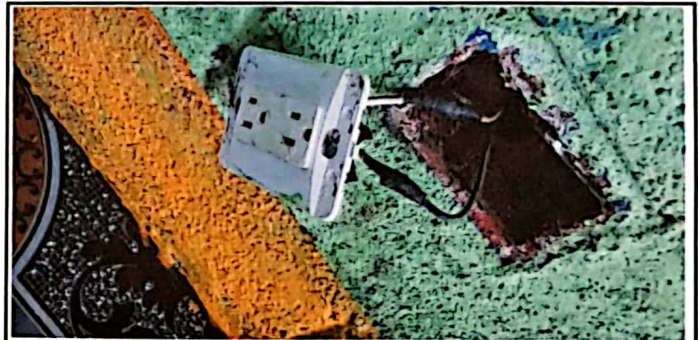
Foto 6: Los interruptores eléctricos en mal estado
