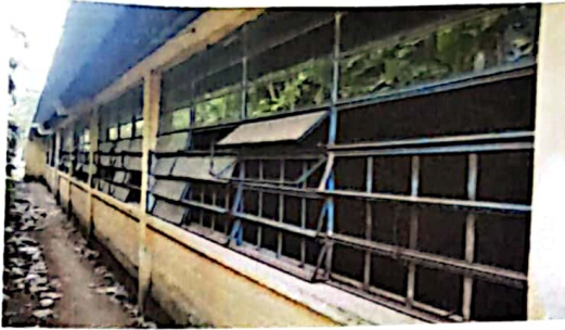
Foto 1: Instalación de balcones en ventanas y bajadas de agua pluvial
