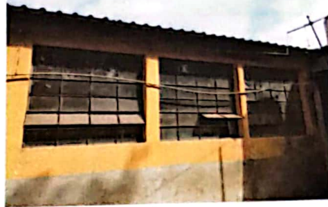
Foto 2: Intalación de balcones y bajas de agua pluvial
